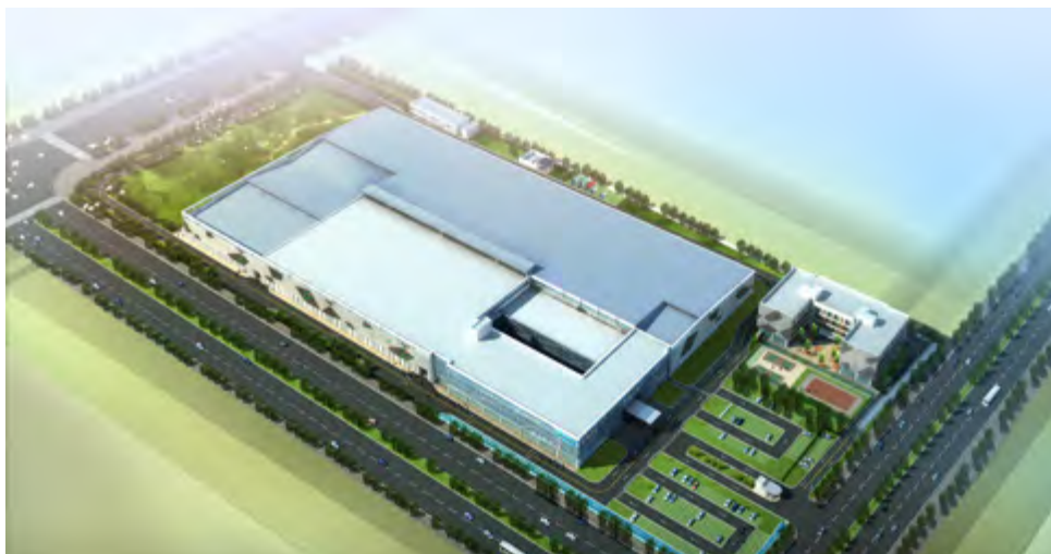
■ 温岭东部新区厂房
