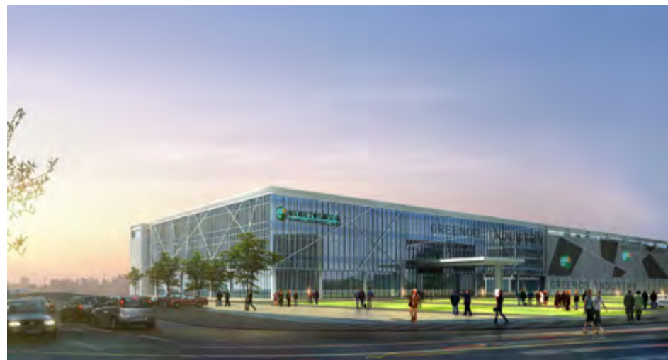
■ 泽国沈桥厂房
